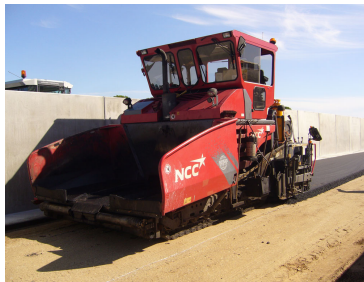
Udlægning af 1. lags asfalt
