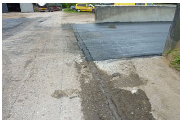
Renovering af betongulv med ny asfaltbelægning Renovering af forplads
