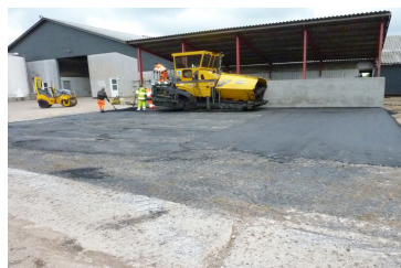
Renovering af betongulv med ny asfaltbelægning Renovering af forplads
